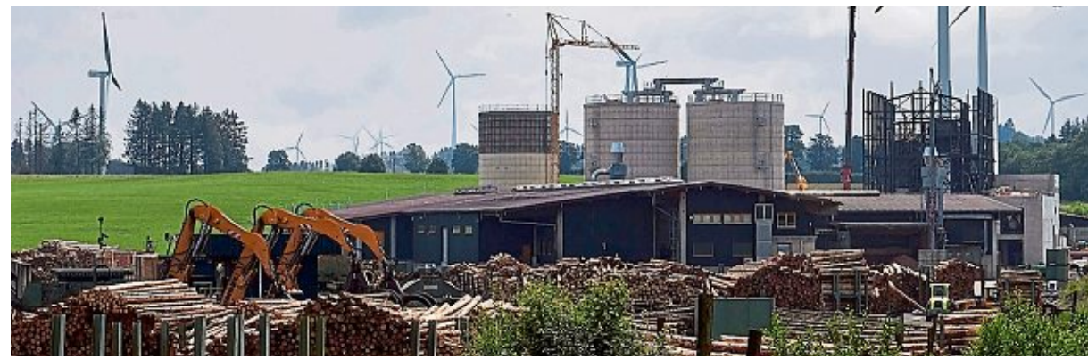
Großsilos und Werkhallen entstehen neben den Hallen, in denen das Sägewerk untergebracht ist. Für deren Betrieb benötigt Hilo auch neue Mitarbeiter.
