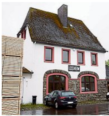
Der alte Losheimer Bahnhof wird nun als Bürogebäude genutzt.
