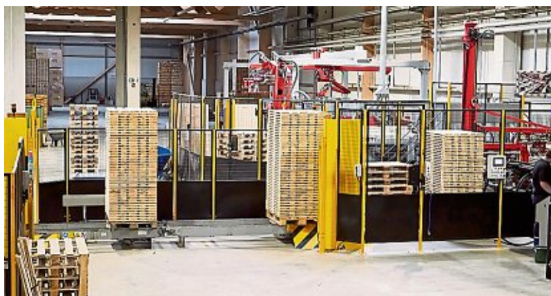
Das Palettenwerk wurde 2022 errichtet. Es ersetzte die alten Anlagen aus dem Vorgängerbetrieb in Hallschlag.
